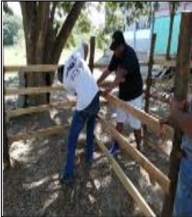
Figura 8. Construcción de corraletas.
