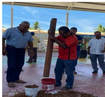
Figura 8. Apisonado de la mezcla para compactarla.
