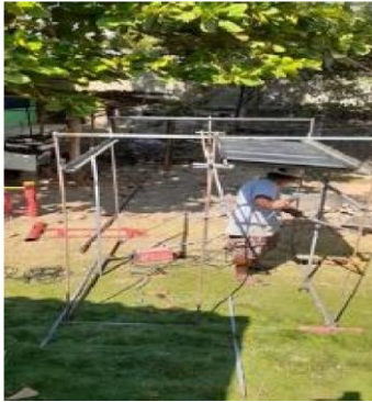
Figura 23. Elaboración de módulos de estructura metálica.
