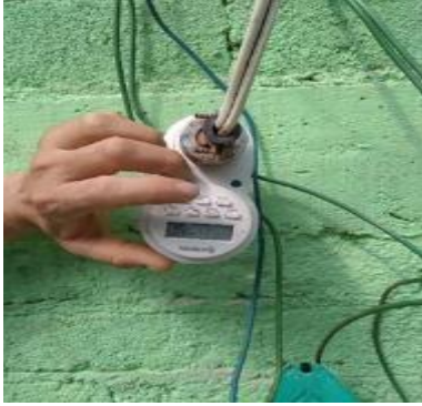
Figura 20. Programación de los riegos con temporizador digital.
