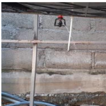
Figura 38. Reparación de microaspersiones tapados en el sistema de riego.
